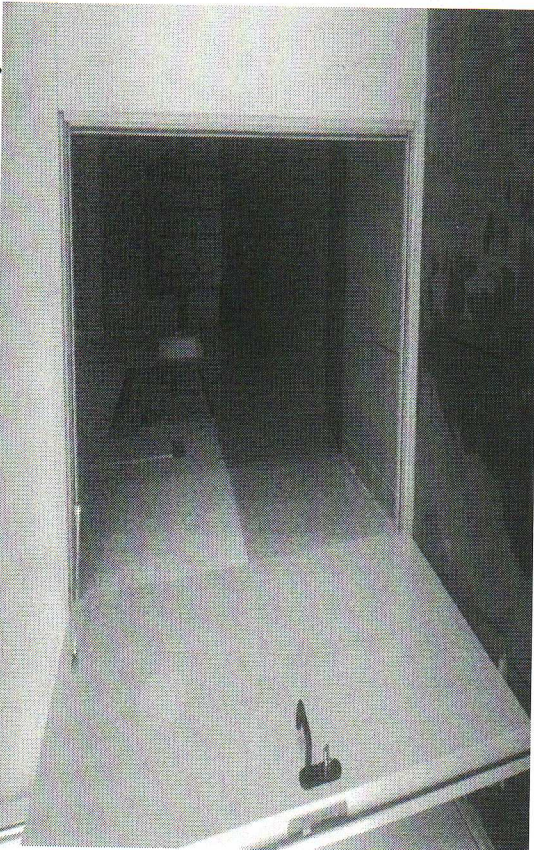
Фото 6. Путь (пути) движения внутри здания (в т.ч. пути эвакуации)
